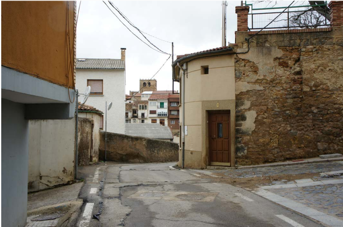
ESTRECHAMIENTO EN LA CALLE TIRADOR EN EL ACCESO A LA PLAZA PUENTE CAÑA
