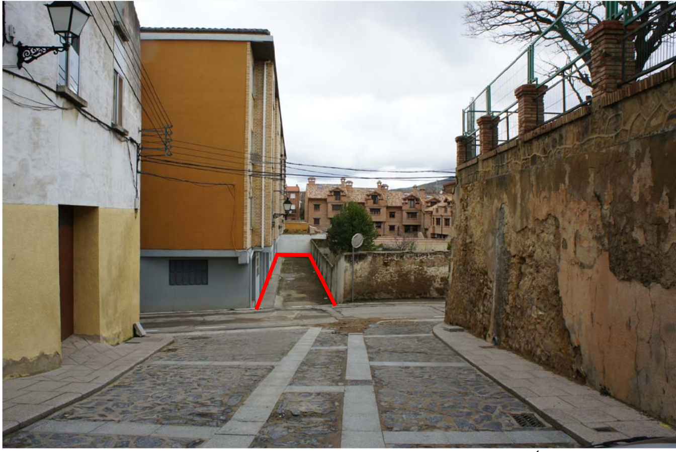
CALLE EN FONDO DE SACO EN LA PROLONGACION DE LA C/ CASTEJÓN
