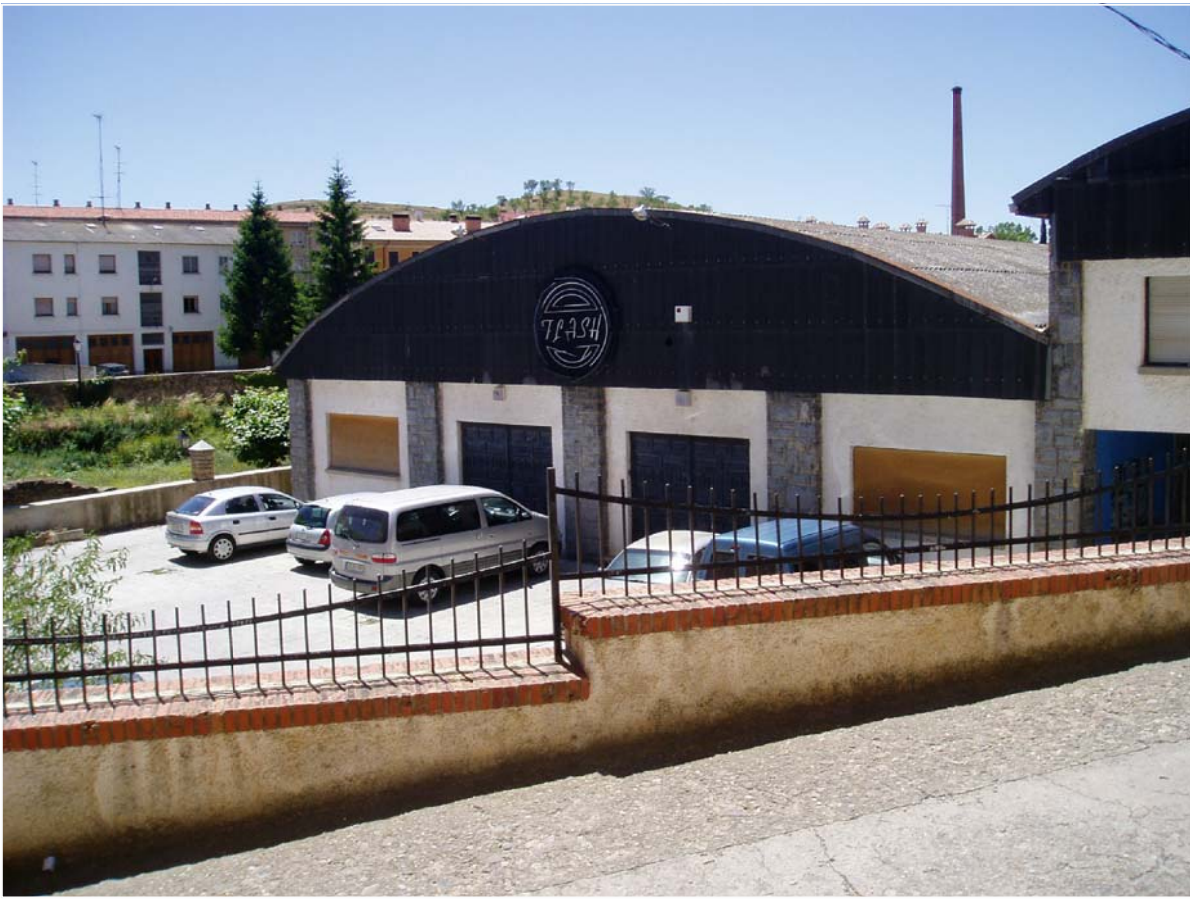
VISTA DEL EDIFICIO DEL CÍRCULO CULTURAL RECREATIVO DESDE LA C/ CASCANTE
