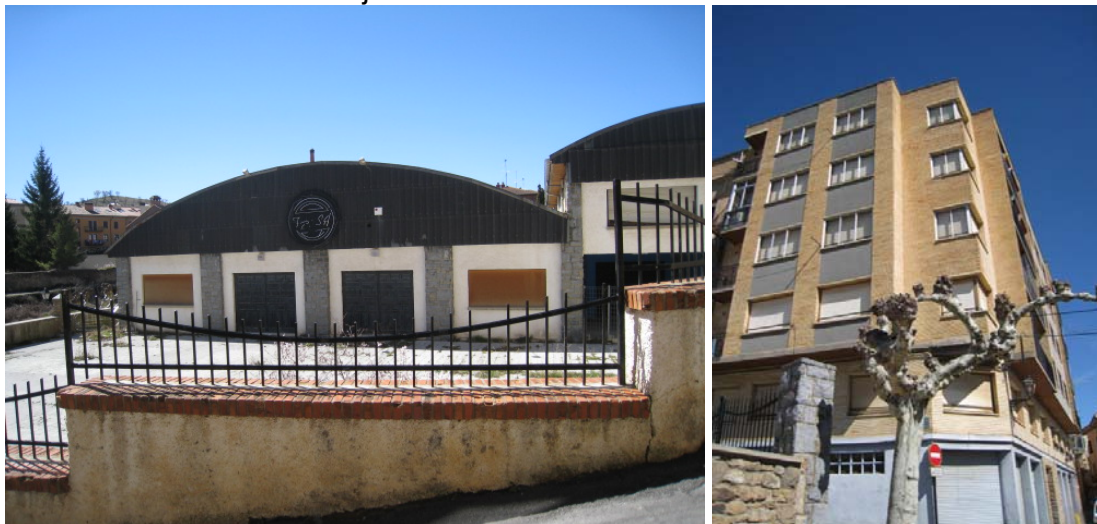
Edificaciones en la plaza Puente Caña: Círculo Cultural Recreativo y edificio de viviendas.
