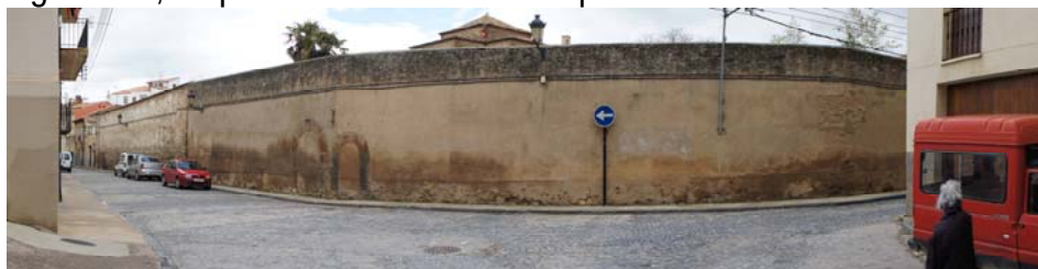
Muro del Convento, hacia la calle Ancha.
