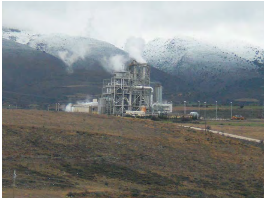
Foto nº 16. Planta de tratamiento de residuos
